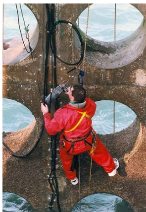
Figure 2 : Instrumentation digue par la pose de capteurs de pression.
