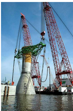
Figure 1 : Fondations gravitaires pour les éoliennes offshore.
